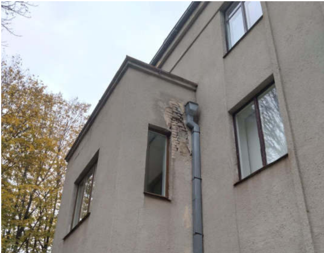
1 pav. Pietinio fasado, trečio aukšto balkono, pažeista balkono hidroizoliacija ir netvarkinga vandens nuvedimo sistema ardo tinko fasadą ir mūrines laikančias konstrukcijas
