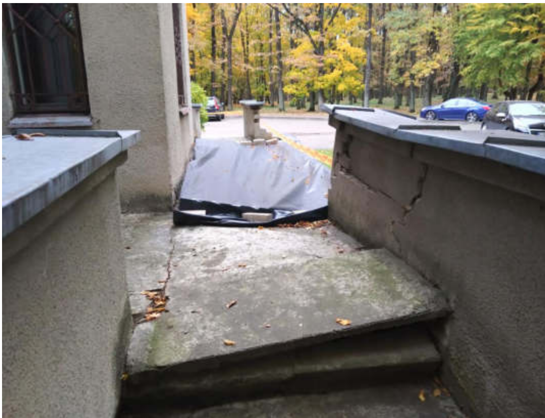
2 pav. Pietinės pusės, pirmo aukšto terasa avarinės būklės, sienutės sutrūkusios ir pasvirusios, dalis sienučių išvirtusios, perdanga įlūžusi ir išsikraipusi, laiptai išsikraipę
