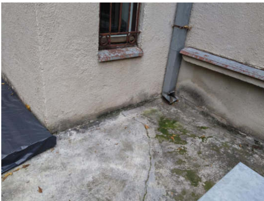
4 pav. Pietinės pusės stogo lietvamzdis nuvestas ant pirmo aukšto terasos perdangos, vanduo plauna terasos konstrukcijas, sienutes, perdangą, pamatus
