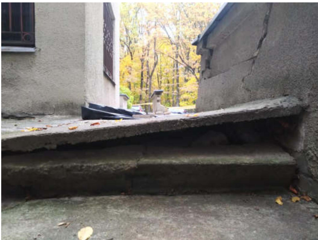
3 pav. Pietinės pusės, pirmo aukšto terasa avarinės būklės, sienutės sutrūkusios ir pasvirusios, dalis sienučių išvirtusios, perdanga įlūžusi ir išsikraipiusi, laiptai išsikraipę
