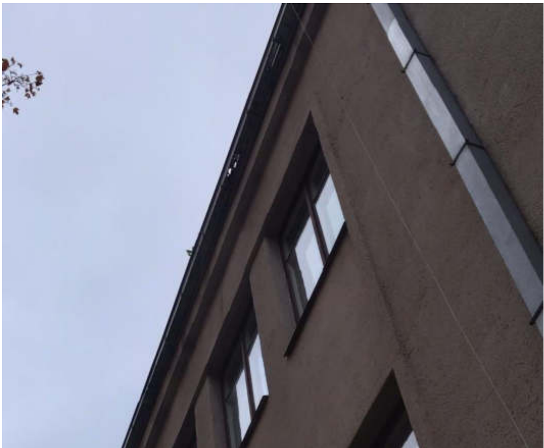
6 pav. Šiaurinio fasado stogo latakai kiaurai perpuvę
