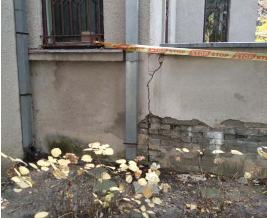
5 pav. Pietinės pusės, pirmo aukšto terasos konstrukcijos atitrūkusios nuo pastato, nuo stogo lietvamzdžiais atbėgantis vanduo plauna cokolį ir pamatus
